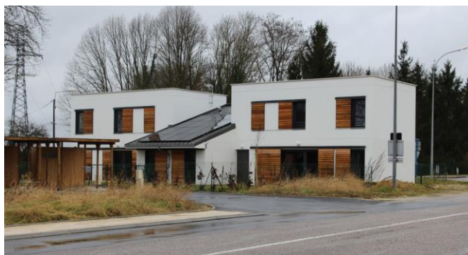
Petits collectifs BBC construits dans le cadre de la politique de renouvellement (Photos Aequilibrium)
